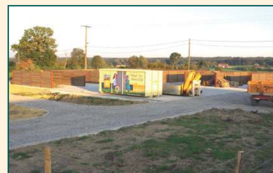
Am Raerenpfad in Kettenis entsteht zur Zeit die Baumschule von „Garden-Service“
